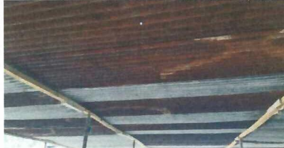
Foto 2: Estructura de techo: Colocacion de costaneras de metal, actualmente son de madera.
