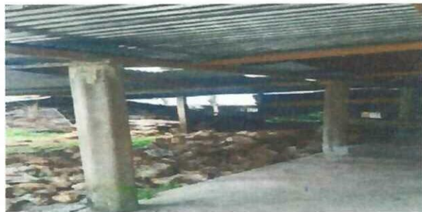
Foto1: Cubierta de lamina. Cambio de techo de la cocina por encontrarse en mal estado.
