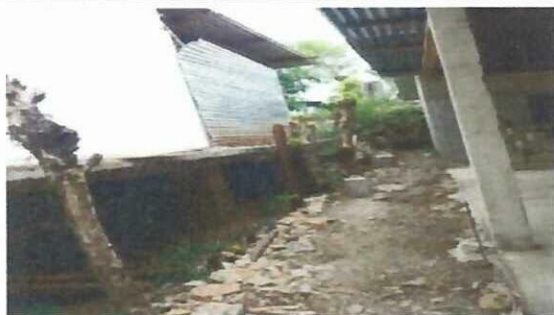
Foto 3: Mejoramiento de pared de cocina: Elevación de pared con block, lo cual dará la seguridad de un comedor para los estudiantes.
