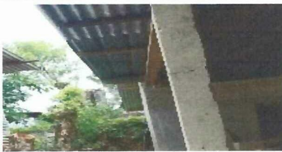
Foto 4: Canales y bajadas pluvial: colocacion de canales a la orilla del techo, evitará filtración de agua en la cocina..
